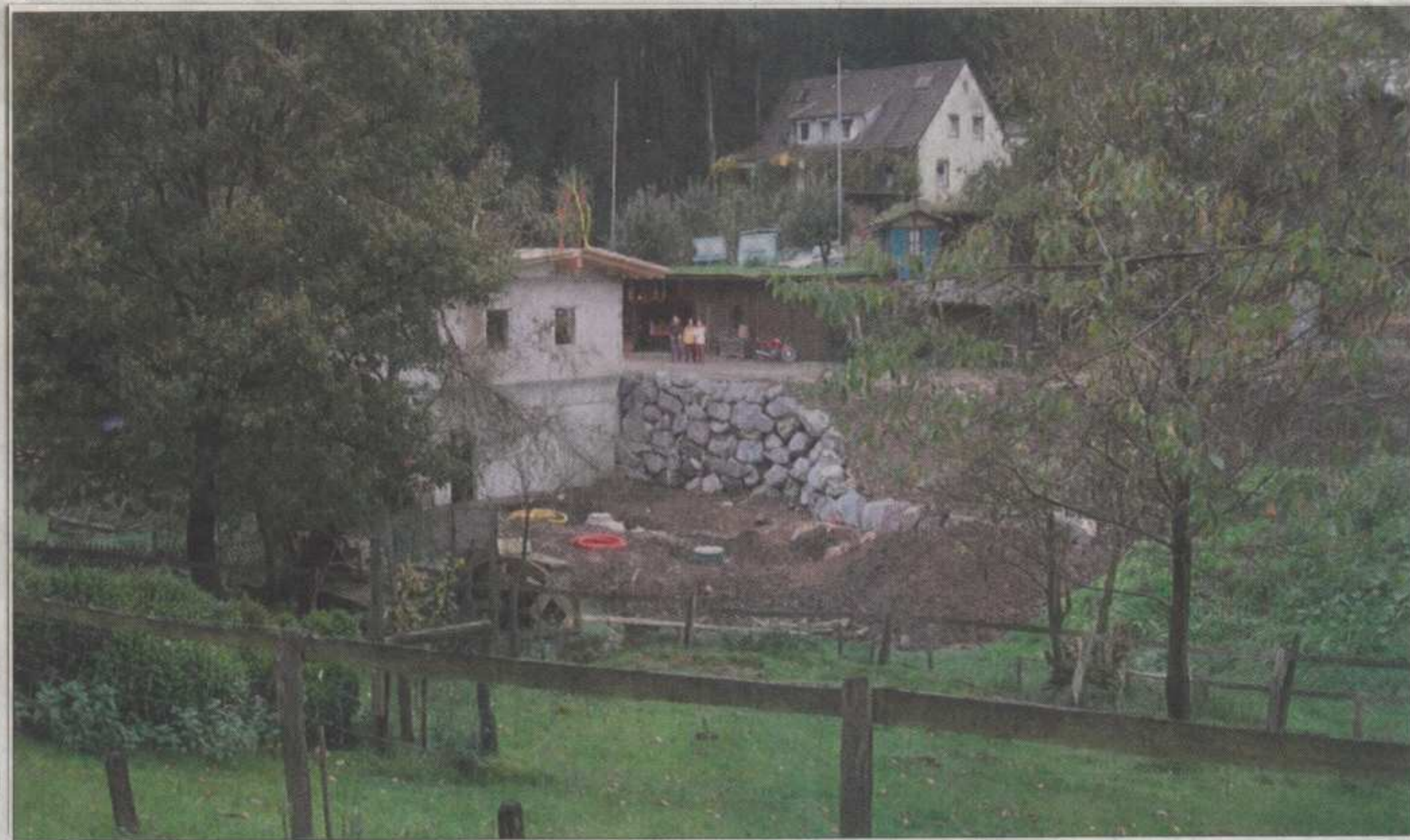
Der Campingplatz Rüggeberg mit dem neuen Empfangs- und Sanitärgebäude (links). Auch gibt es neue Stellplätze für Touristen und eine Zeltwiese. Unser Bild wurde von der Severinghauser Straße aus aufgenommen. (WR-Bild: Angelika Trapp)
