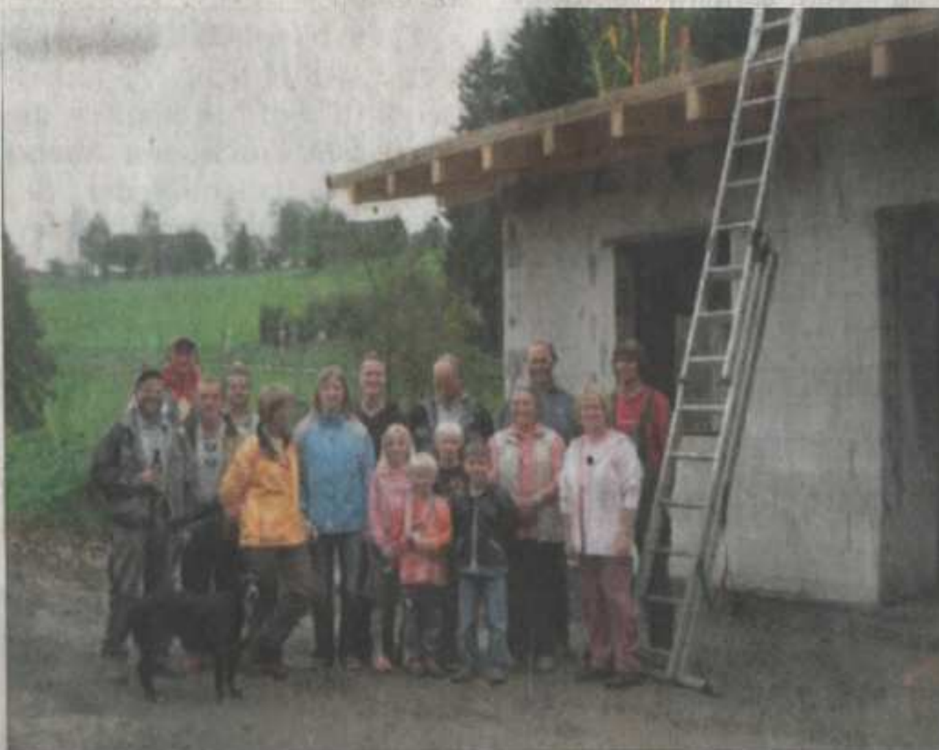
Richtfest am Empfangs- und Sanitärgebäude mit Familie Steffen-Mester, Bauleuten und Anita Schöneberg (WR-Bild: Trapp)
